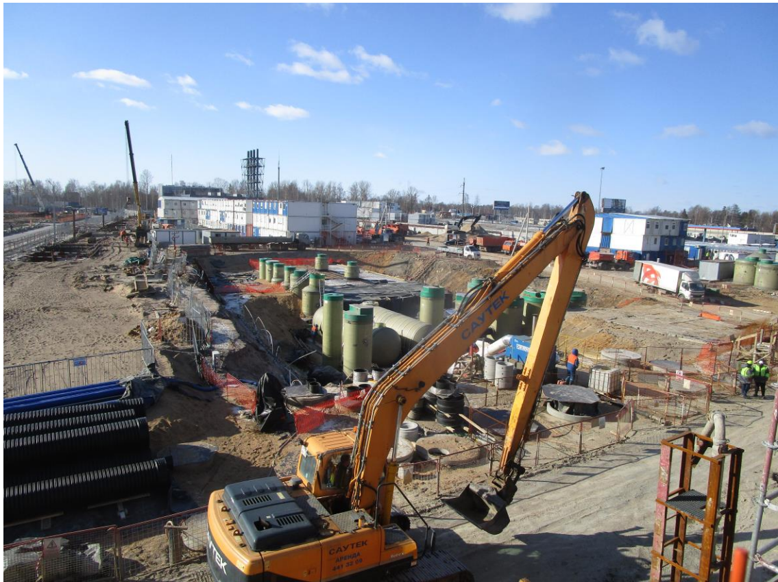
Организация земляных работ при устройстве наружных сетей на объекте «Лахта-центр»
