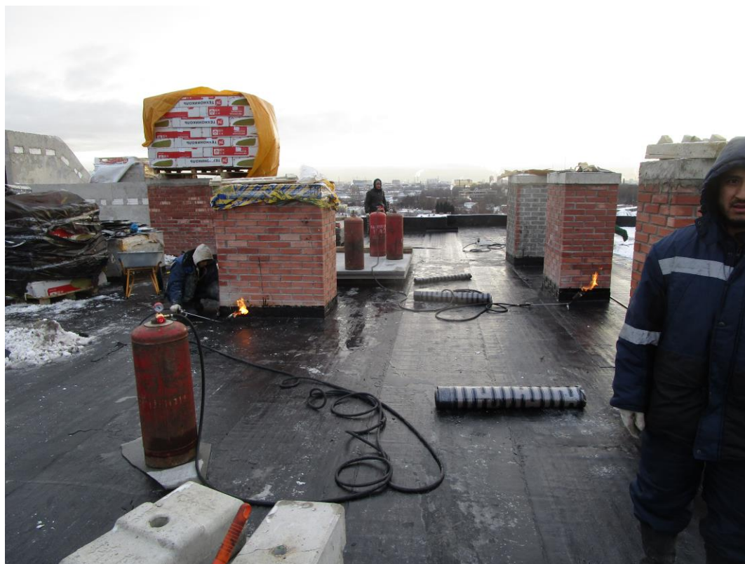
Устройство мягкой кровли
