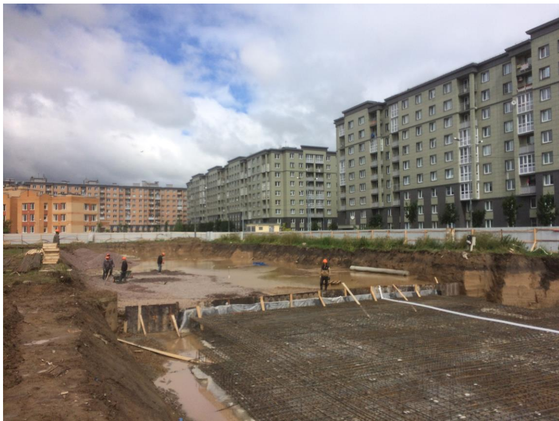
Фрагмент устройства основания под фундаментную плиту здания Устройство арматурного каркаса монолитной железобетонной фундаментной плиты
