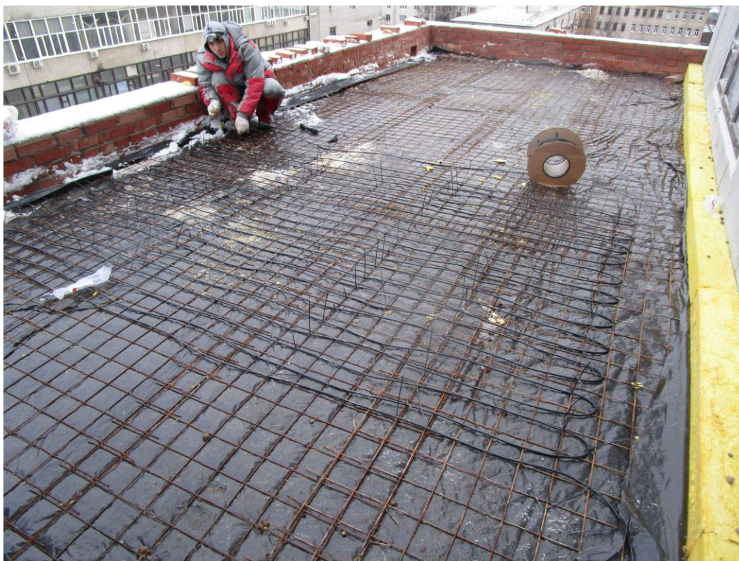
Фрагмент устройства тёплого пола террасы жилого дома
