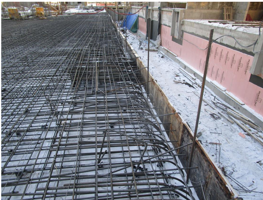
Фрагмент устройства арматурного каркаса и коммутации системы электропрогрева греющим проводом монолитной железобетонной фундаментной плиты.
