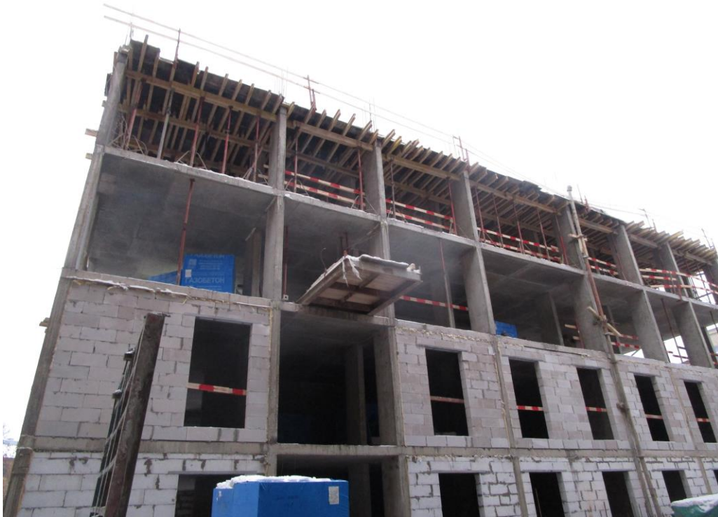
Фрагмент устройства монолитного железобетонного каркаса здания с устройством самонесущих наружных стен из газобетона.
