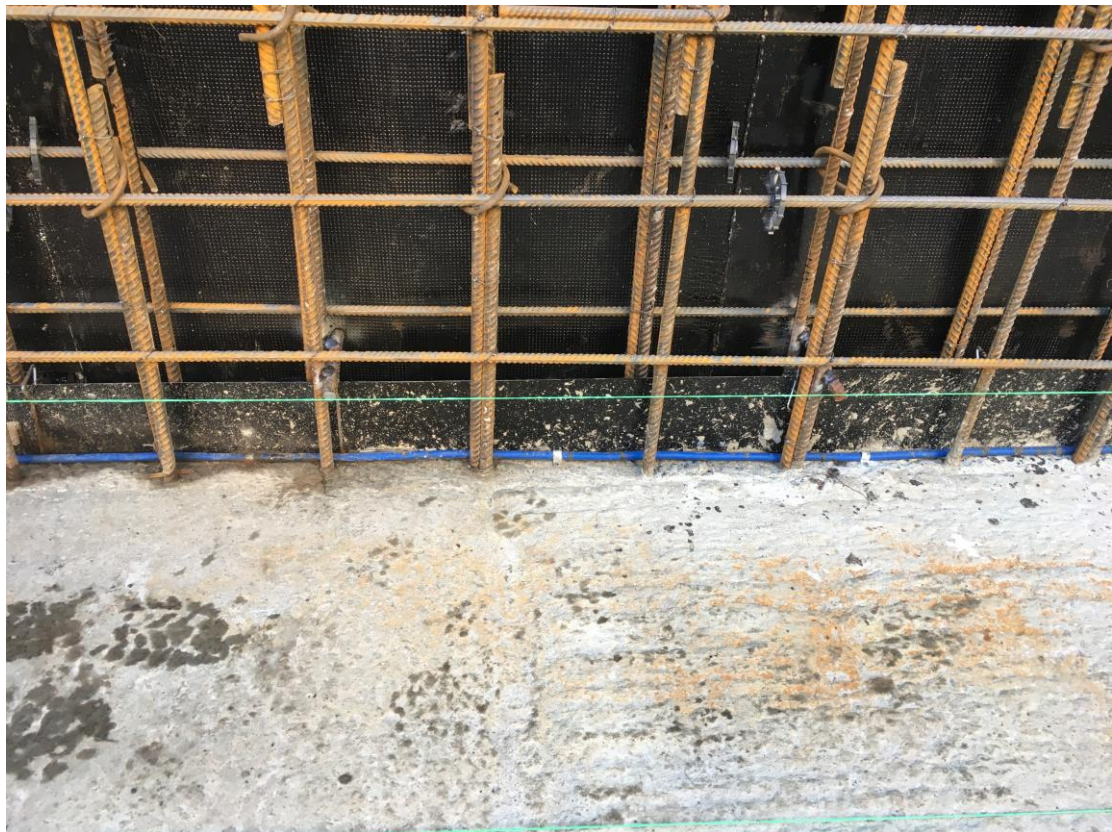
Фрагмент устройства каркаса монолитной железобетонной стены Узел устройства гидрошпонки ГП-150 и инъектсистемы
