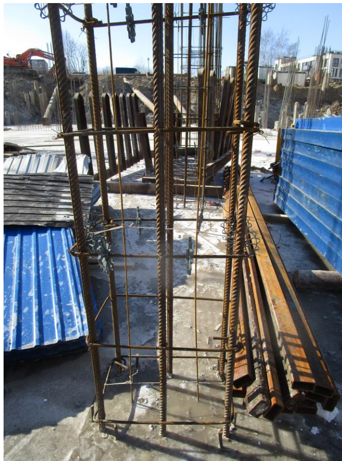
Устройство арматурного каркаса монолитной железобетонной колонны Коммутация электропрогрева стержневыми электродами
