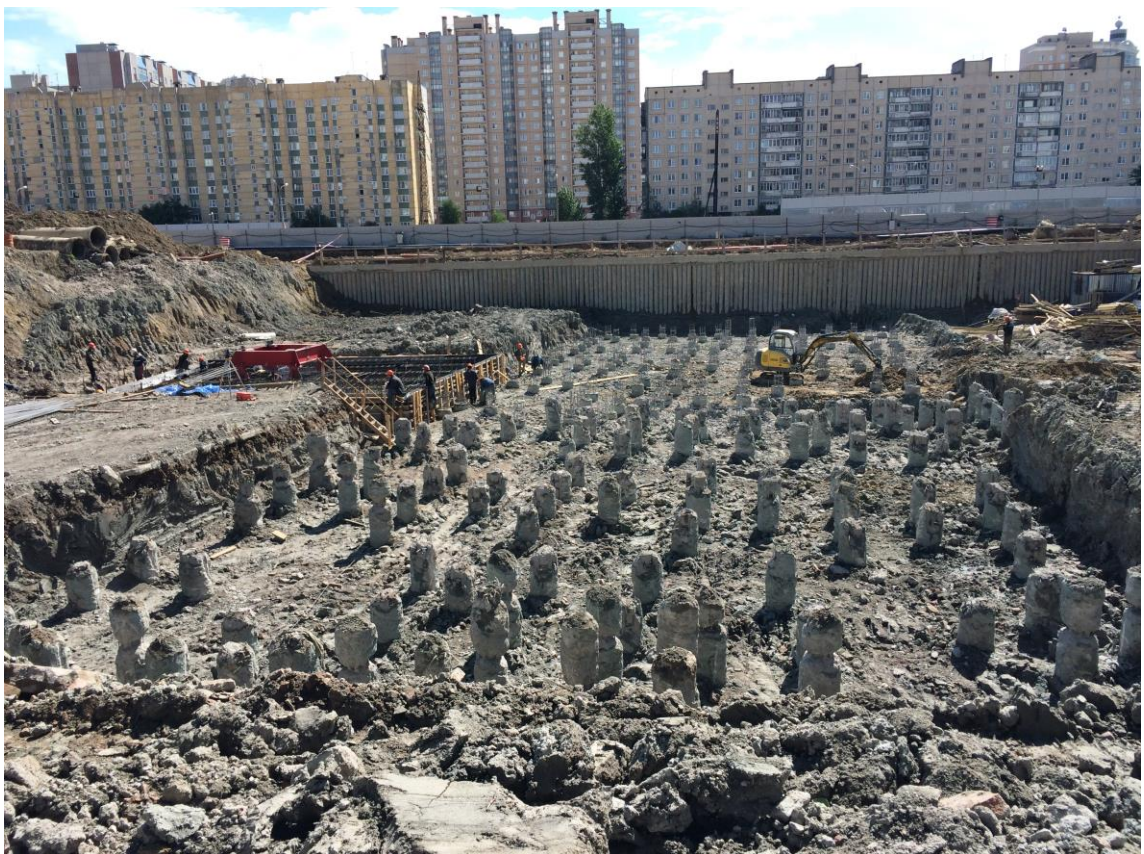
Фрагмент устройства свайного основания из буронабивных свай
