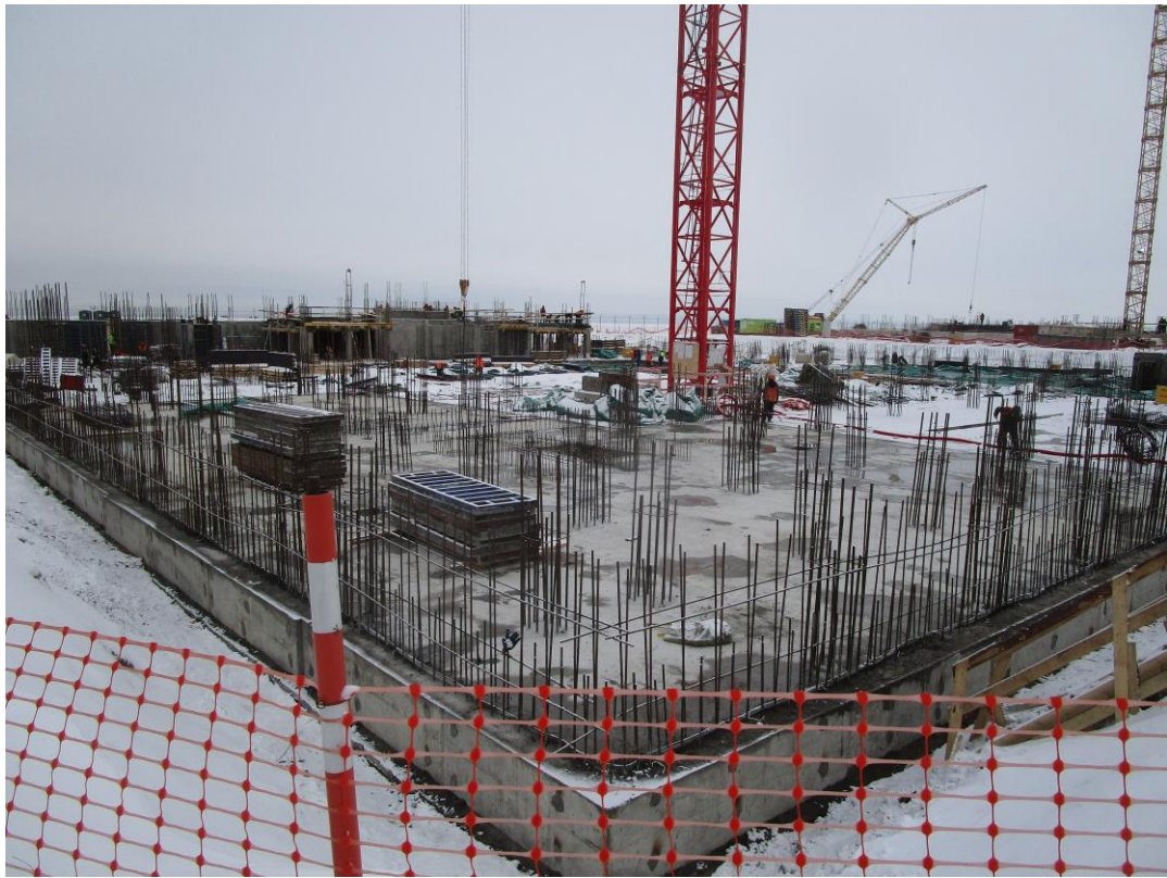
Фрагмент устройства монолитной железобетонной фундаментной плиты
